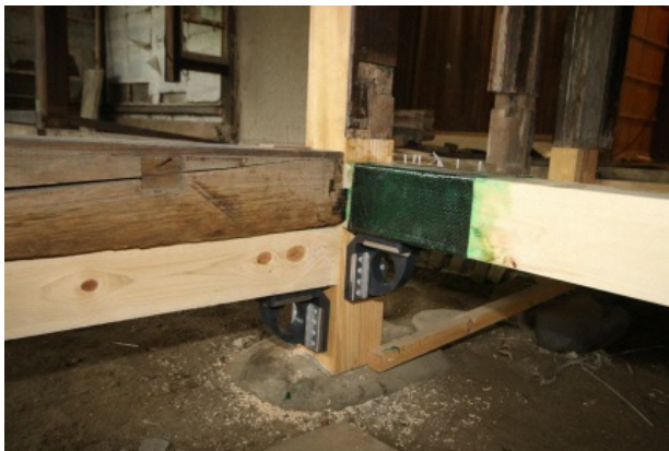
仕口ダンパー設置状況
