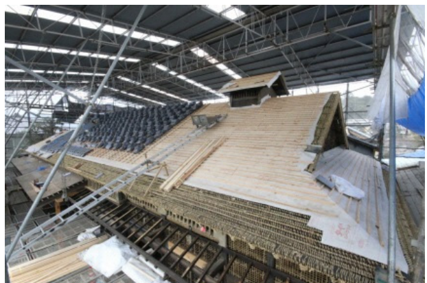
屋根瓦下地の状況 (改修後：空葺き)
