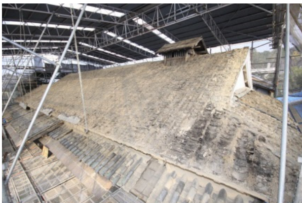
屋根瓦下地の状況 (改修前：土葺き)
