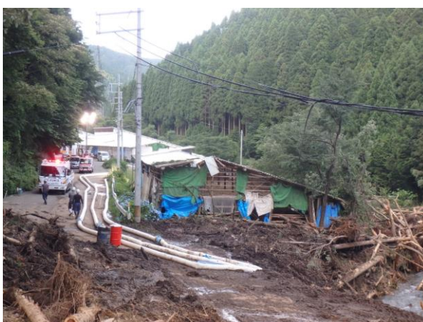
排水ポンプ車による土砂ダムの 応急対策（近畿地方整備局） 兵庫県宍粟市 7.10
