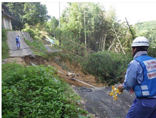
被災状況調査（関東地方整備局） 岡山県吉備中央町 7.11
