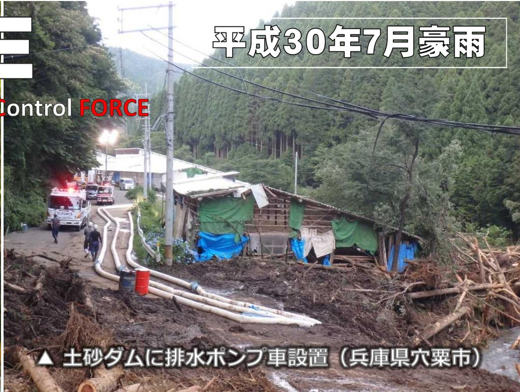
▲土砂ダムに排水ポンプ車設置（兵庫県穴栗市）
