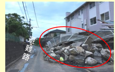
小規模造成宅地被害事例
