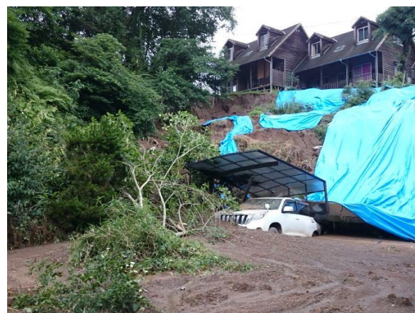
大規模盛土造成地の滑動崩落
