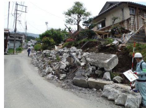
被災宅地危険度判定実施状況
