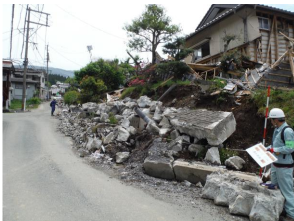
小規模な宅地擁壁の崩壊
