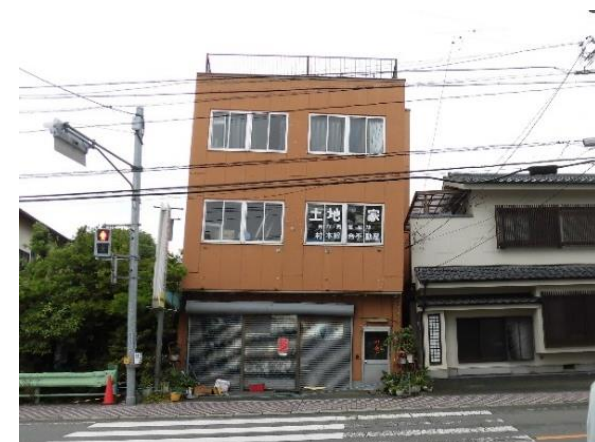
液状化被害による不同沈下・建物傾斜
