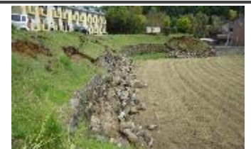
公共施設等に影響がない宅地擁壁の被害例
