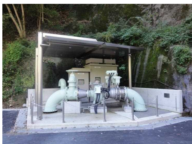
平成24年度に運用を開始した小水力発電施設
