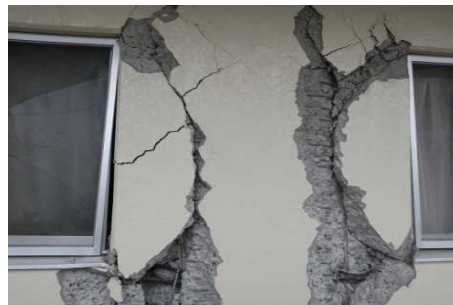
熊本地震における非構造壁の損傷
