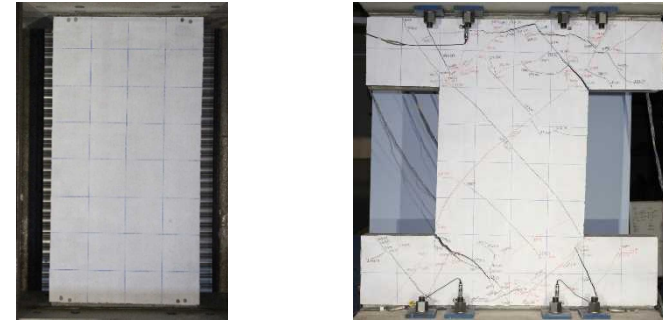
PCM補強方立壁は損傷が少なく、曲げ破壊モードとなる。
