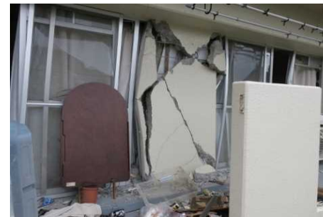
熊本地震における非構造壁の損傷
