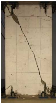
既存方立壁の最終破壊
