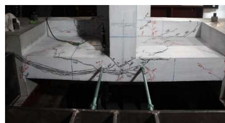
図 6 アンカー部の破壊状況
