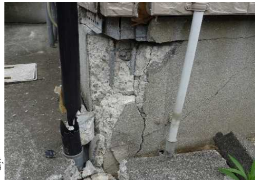
図2 地震時の出隅部の被害
