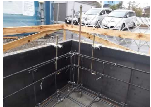
図1 出隅部分の配筋状況
