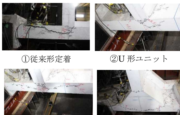
図 5 各定着形式ごとの破壊状況
