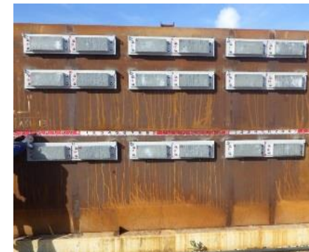
試験片の岸壁への設置
