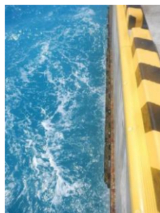
岸壁に設置された試験片
