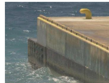
岸壁に設置された試験片
