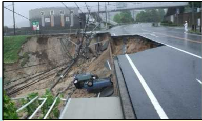
① 国道201号 福岡県飯塚市 【盛土法面の崩壊】
