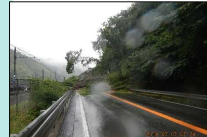
⑥ 国道27号 京都府舞鶴市 【切土法面の崩壊】
