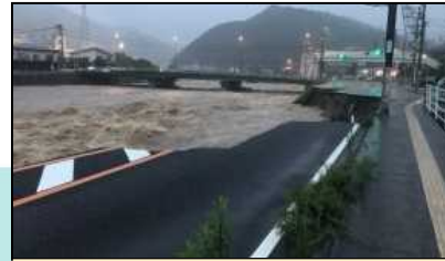
③ 国道2号 広島県広島市 【車道部の洗掘】
