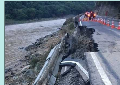
⑤ 国道180号 岡山県総社市 【車道部の洗掘】
