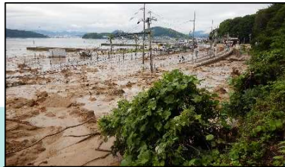
② 国道31号 広島県安芸郡坂町 【区域外からの流木・土砂等の流入】
