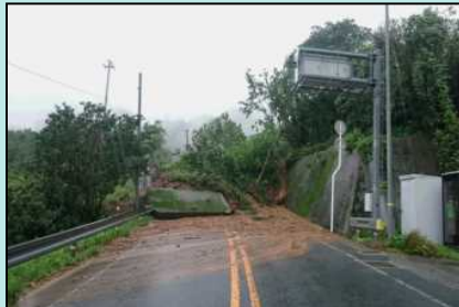
④ 国道56号 愛媛県宇和島市 【切土法面の崩壊】
