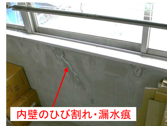
内壁：ひび割れより漏水が発生している
