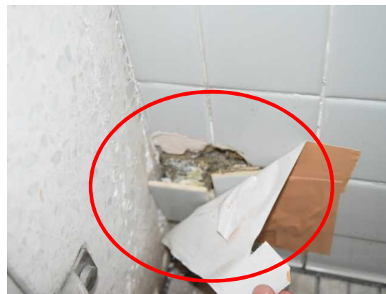
内壁：タイルのひび割れや欠損がみられる
