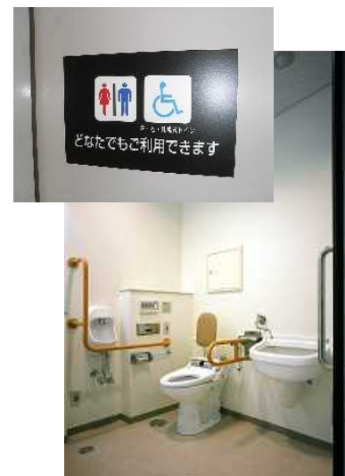
多様な利用者に配慮した 多機能トイレの整備
