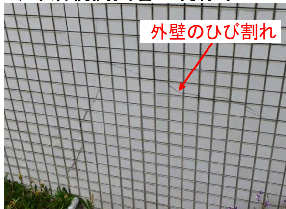
外壁：ひび割れが発生している
