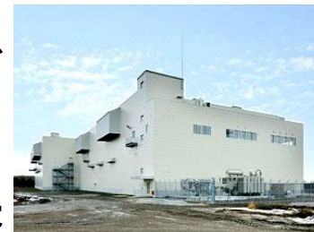
出典:ほくでんHP 南早来変電所大型蓄電池(建屋外観)
