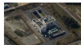
浦安ポンプ場(浦安排水区) 平成27年3月 356m 3 /min増強 排水能力 792m 3 /min
