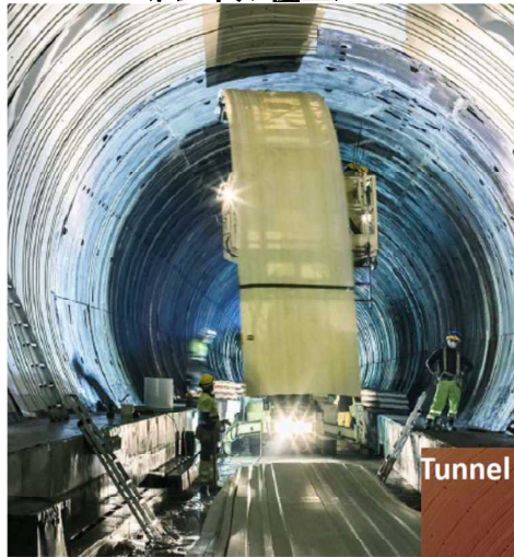
〈トンネル覆工〉
