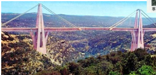
Wadi el Kuf Bridge, Libya
