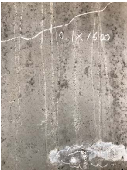
ひび割れ・カルシウム成分漏出
