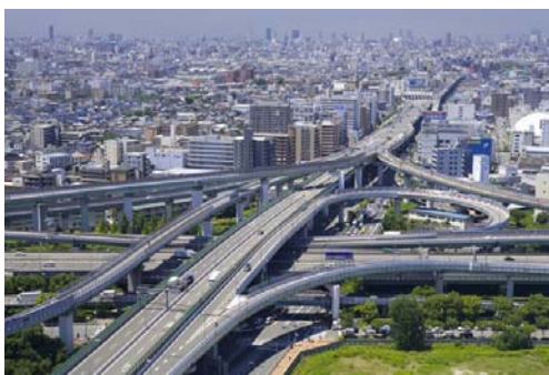
長さ15m以上の道路橋の総数：約16万橋
