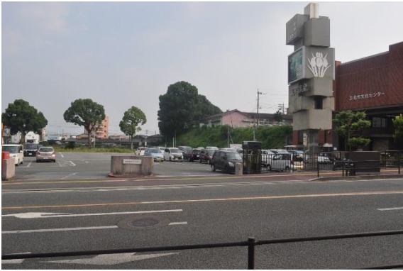
本庁舎跡地全景（国道 208 号より）
