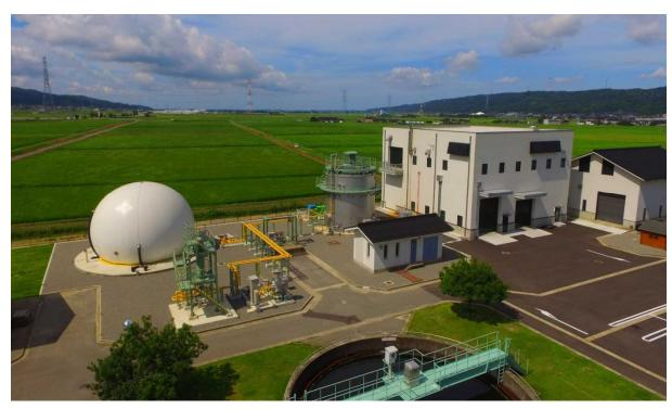
※「メタン活用いしかわモデル」は、石川県が産学官連携で研究・開発を進めてきた小規模下水処理場向けの混合バイオマスメタン発酵システムです。
