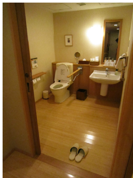
トイレ・洗面室 出入口の前後に高低差はない。 トイレには、縦手すり及び跳ね上げ手すり、洗面台の横には横手すりが設けられている。
