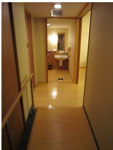
玄関スロープ（客室内部） 横手すりが片側に設けられている。
