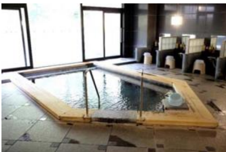
手すりが設けられた浴槽
