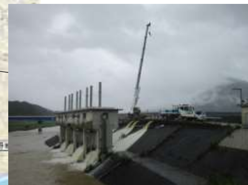
都谷川樋門排水状況
