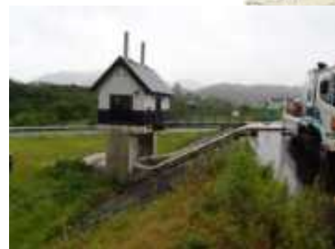
武田川樋門排水状況
