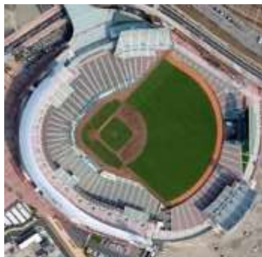
大州雨水貯留池 上部利用
