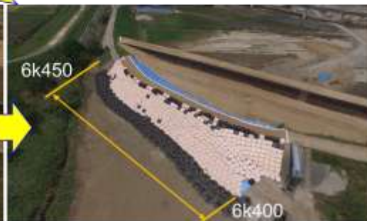
7月19日(木) 14:30 応急復旧対策完了 7月19日(木) 12:00撮影
