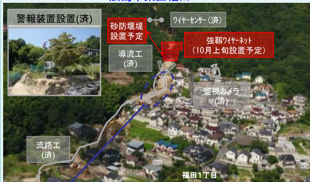
直轄による実施状況(例) 広島市東区福田 ひがしくふた
