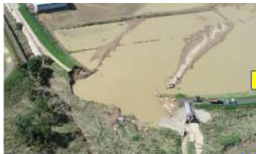
7月8日(日) 14:30に緊急対策工事に着手7月8日(日) 15:00撮影
