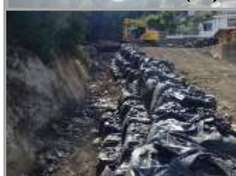
仮設流路工完成(済)
