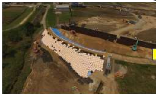
二重締切堤防(二重鋼矢板)施工中 7月16日(月) 13:00撮影
