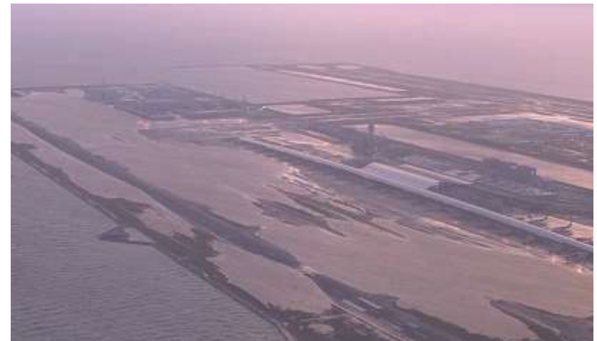
平成30年台風21号による関西空港における高潮被害
