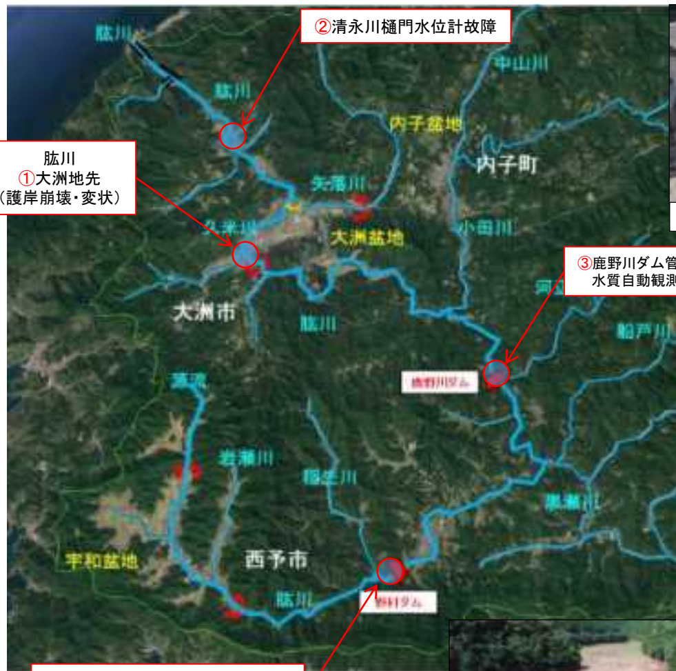
④ 流木(板ヶ谷上流)1,500m2(300m3) 野村ダム、法崩れ 野村ダム、路肩崩壊
