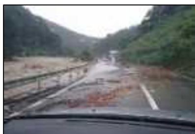
内子町 麓川右岸 巡視
