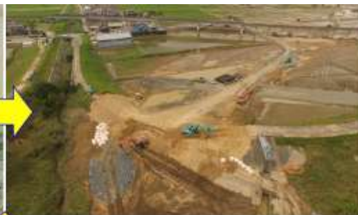
堤防締切盛土施工中 7月13日(金) 13:00撮影
