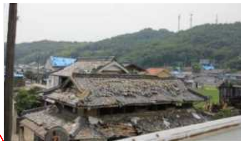
爆発した工場周辺の状況
