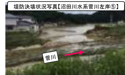
堤防決壊状況写真【沼田川水系菅川左岸⑤】
