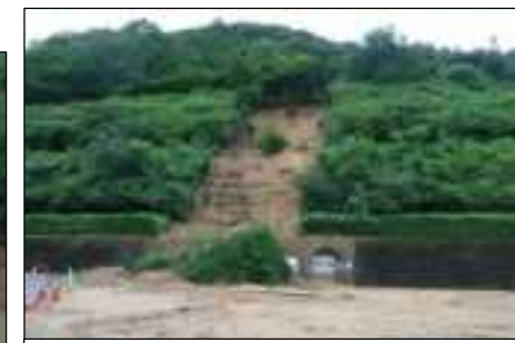
④ 野村ダム、法崩れ
