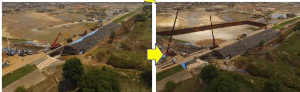
大型土のう施工中 7月15日(日)15:00増撮影
