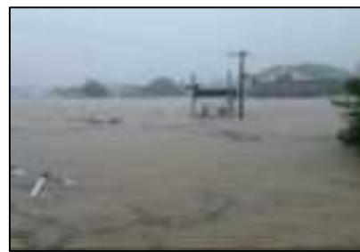
西予市 ダム下流はん濫
