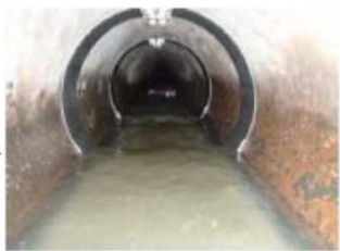
バンドによる管底への固定
