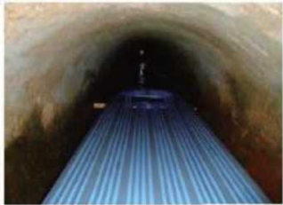
バンドによる管底への固定
