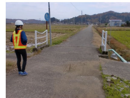
市町村管理の橋梁 5m未満のコンクリート橋が多数 H23より タブレット端末利用の小規模橋梁点検システム (概略点検システム)を開発⇒新潟県内の自治体で実地試験
