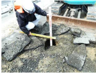
舗装下にφ30cm×深さ70cmの空洞
