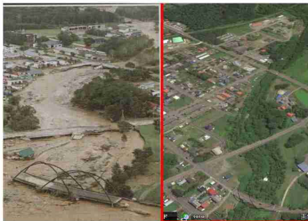
9月1日掲載北海道新聞と被害前の写真比較 ベケレベツ川石山橋
