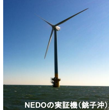
【洋上風力発電設備のイメージ】
