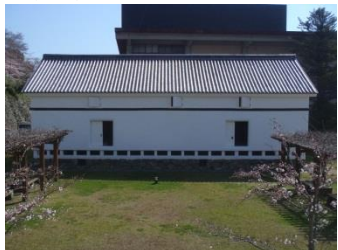
改修後の大洲城下台所
