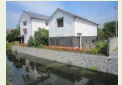
■石積護岸の整備(整備後)
