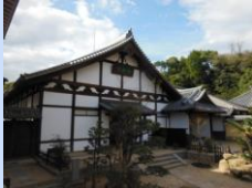
浄土寺の保存修理 (整備後)
