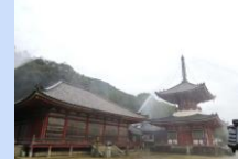
浄土寺に設置した防災設備
