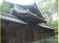
重要文化財向日神社本殿
