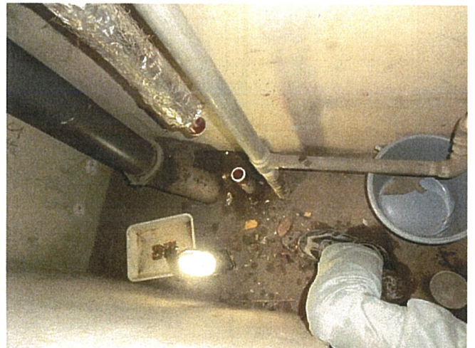
給水管抜管作業 (410 号室 MB)
