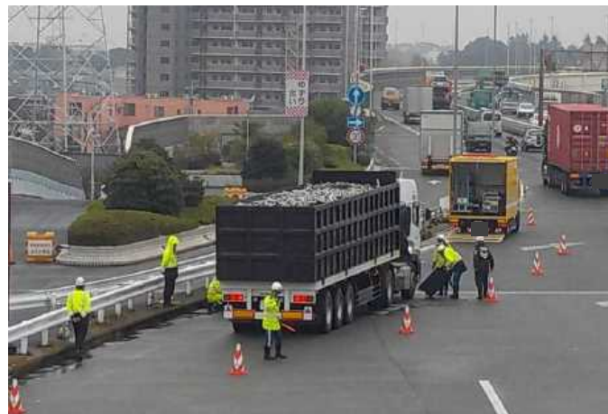
⑤【首都高速道路(株)】川口本線料金所
