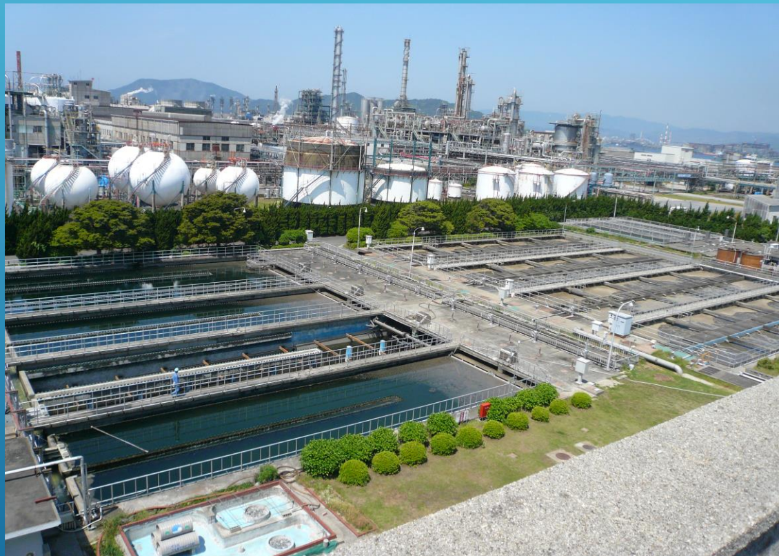
徳山中央浄化センター 水処理施設
