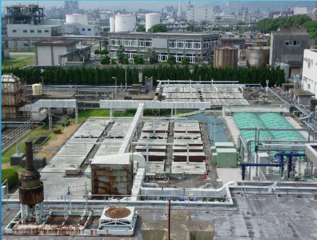
最初沈殿池周辺
