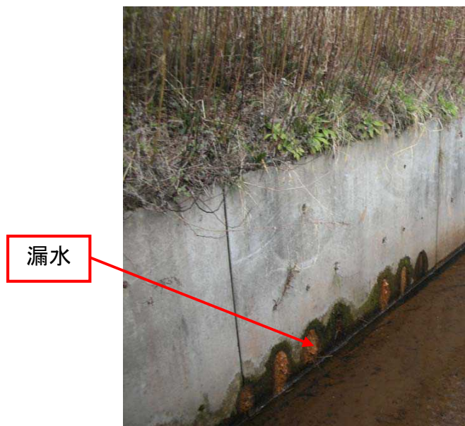
図 2.8 堤脚水路からの漏水
