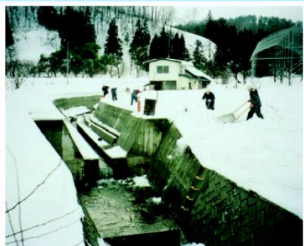
除排雪低水路(山形県村山市)
