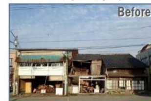
空き家の除却
