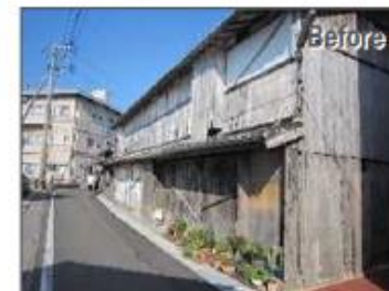
空き家の除却
