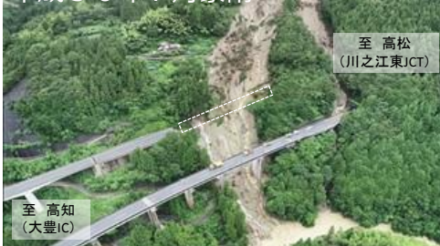
高知道の被災状況 平成30年7月豪雨
