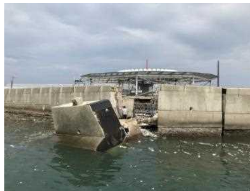
<一部護岸の転倒>
