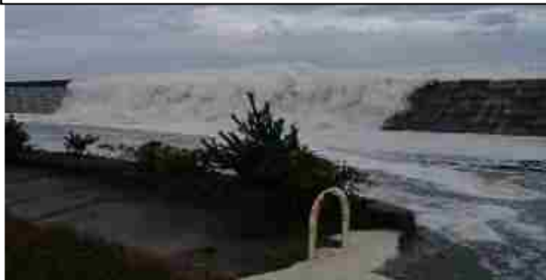
高潮による堤防越波状況
