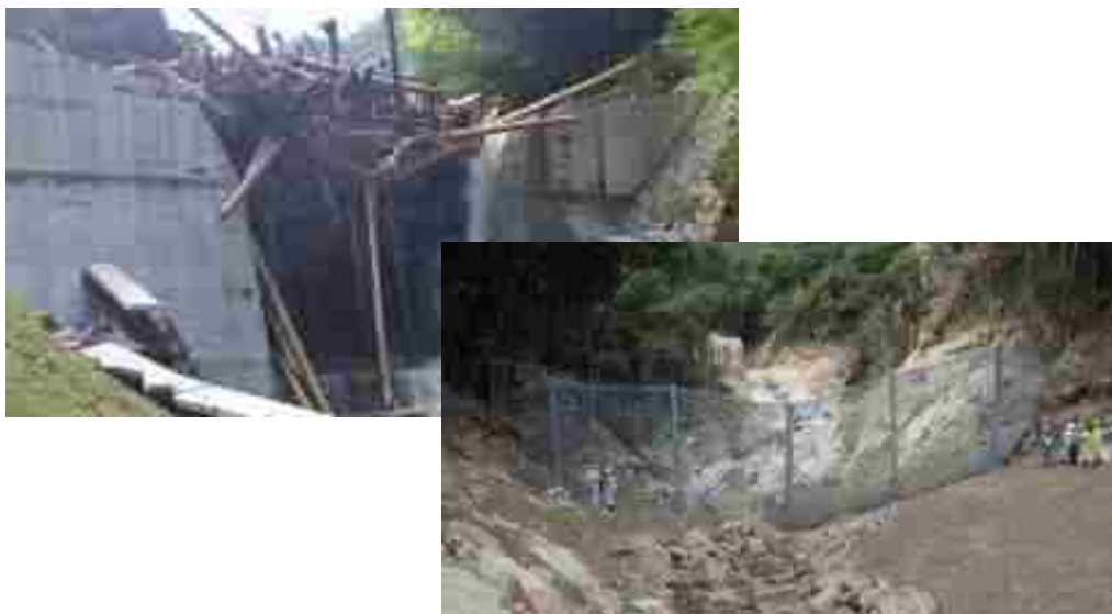
砂防堰堤(左)と強靱ワイヤーネット工(右)の整備イメージ
