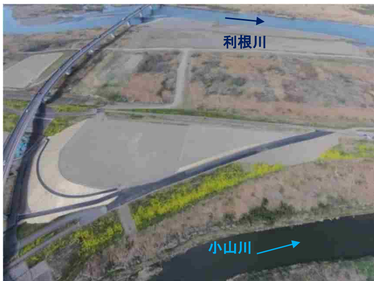
下高島地区(埼玉県深谷市)
