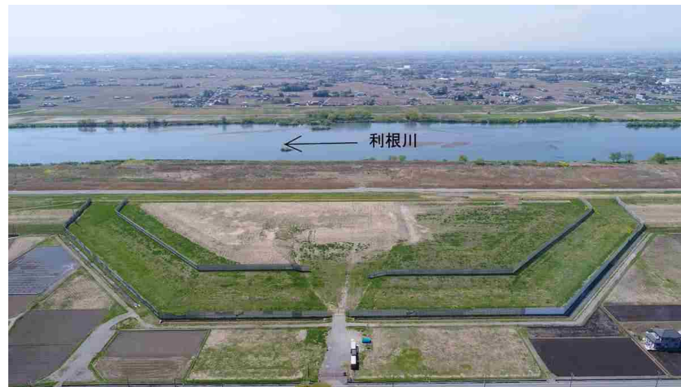
栄地区広域避難地(埼玉県加須市)
