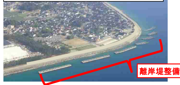
離岸堤の整備による高潮対策事例
