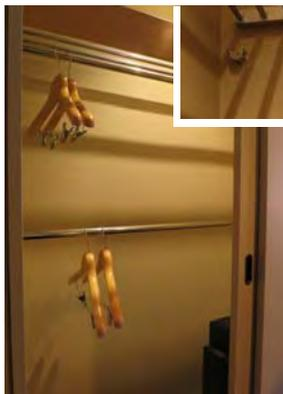
・金物を2カ所に設置し、ハンガーパイプを低い位置に移動できるようにした収納
