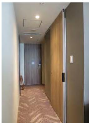
・引き手を彫り込み形式とし、70cmの有効幅員を確保した便房・浴室等の出入口
