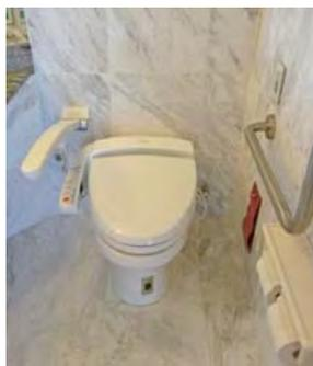
・L型の手すりと跳ね上げ式の手すり
