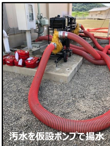
今回の豪雨において河川氾濫により下水処理場が浸水し機能停止したが、被災後3日後には最低限の下水処理機能を確保した事例。(岡山県倉敷市)
