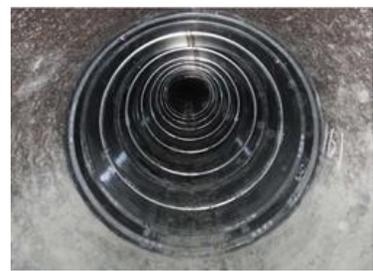
応急対策完了状況(SUS巻鋼管)
