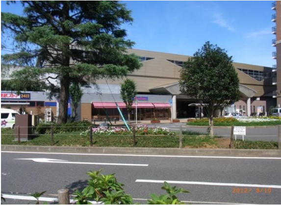
駅前広場を東側から
