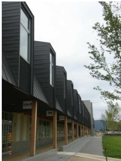
オガールプラザ北側外観
