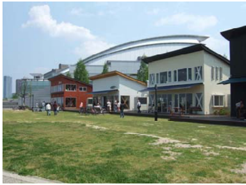
なぎさのテラス(※まちづくり大津 HP より)
