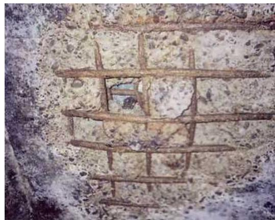
コンクリートが腐食し、鉄筋が露出した管路施設
