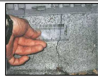
基礎のひび割れ幅の計測
