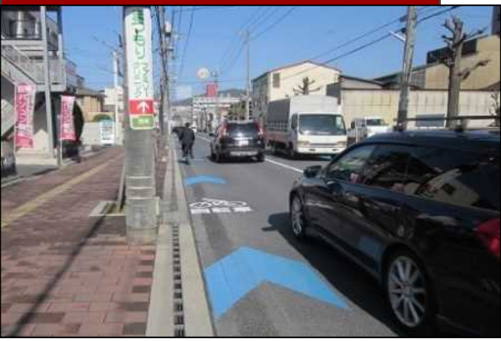
車道混在※ (矢羽根型路面表示)
