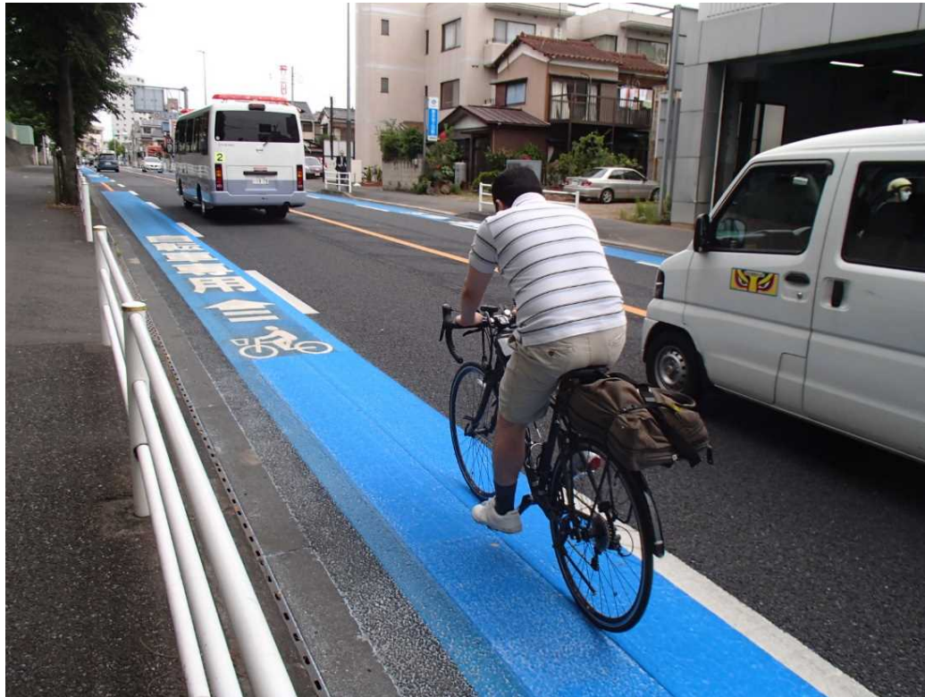
路肩等の空間を活用した 自転車専用通行帯の整備 〔国道17号 埼玉県さいたま市〕
