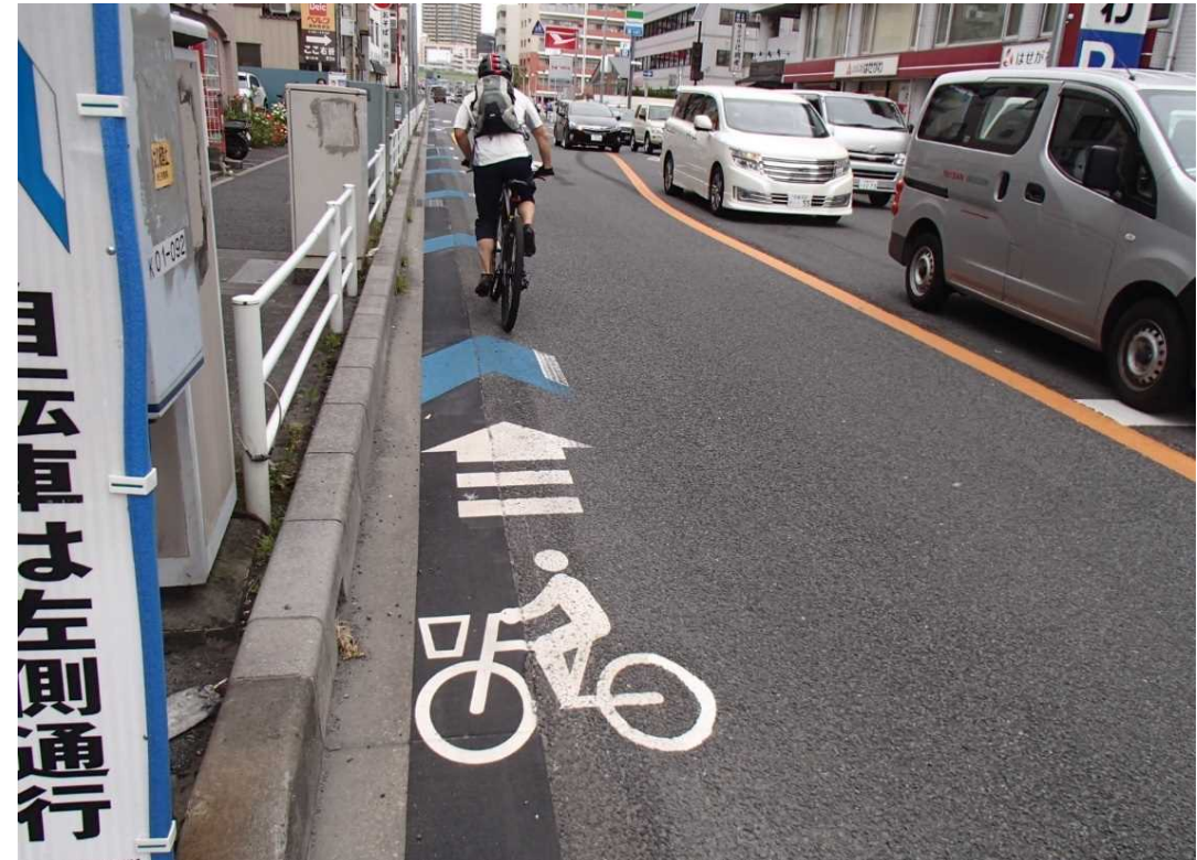
ピクトグラムによる 自転車通行位置の明示(車道混在) 〔国道17号 埼玉県さいたま市〕
