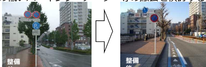
<パーキングメーターの撤去による自転車専用通行帯整備事例(横浜市)>【出典:警察庁】
