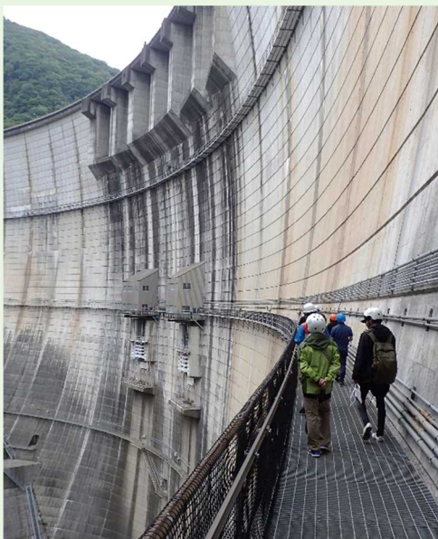
地元民間事業者がキャットウォーク を案内 （川治ダム・栃木県）
