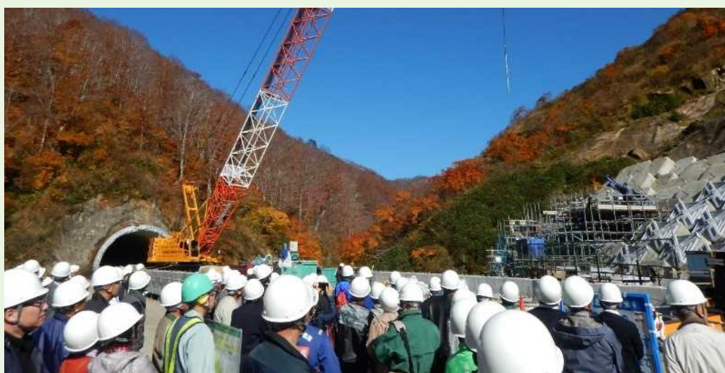
工事現場見学と周辺資源の組み合わせによる魅力の増大(国道 289 号 八十里越)
