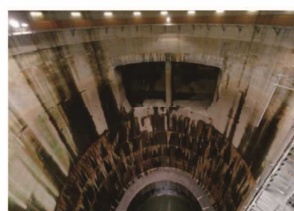
深さ 70m の第 1 立坑 の見学
