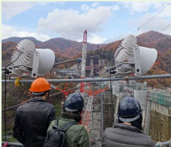
ダム建設中の多彩な見学ツアーの実施による魅力 UP （ハッ場ダム・群馬県）
