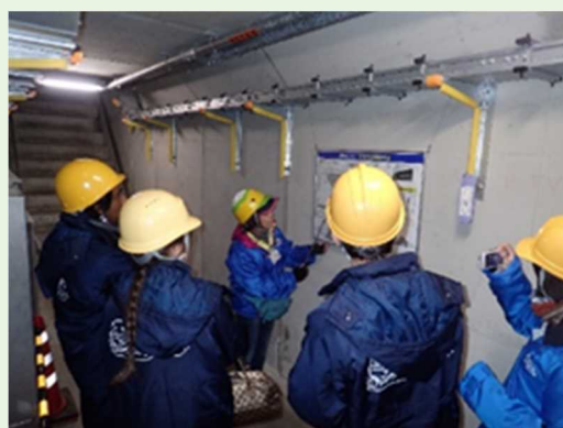
水陸両用バス事業者が監査廊を案内 (湯西川ダム・栃木県)
