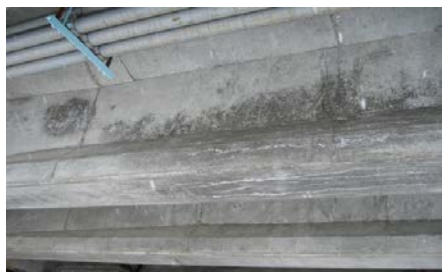
※写真はPC桁下面のひびわれ事例
