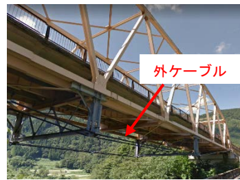
鋼橋の外ケーブル補強の例
