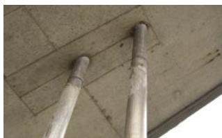
ステンレスの管で保護されている
