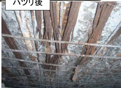
※写真はPC桁下面のひびわれ事例
