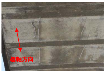
※写真は吊床版橋下面のひびわれ事例
