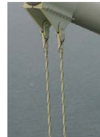
被覆されたハンガーに制震ロープが配置されている例
