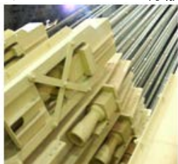
アンカーフレームに分散させて定着
