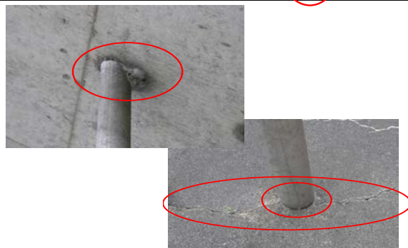
内部の腐食を疑わせる変状
