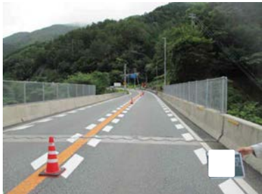
浮き上がりが無いか確認する
