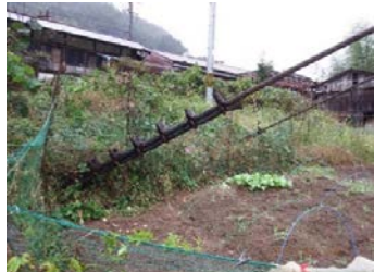
ワイヤークリップによる端末処理
