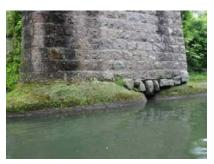
例 橋脚に洗掘が生じている例
