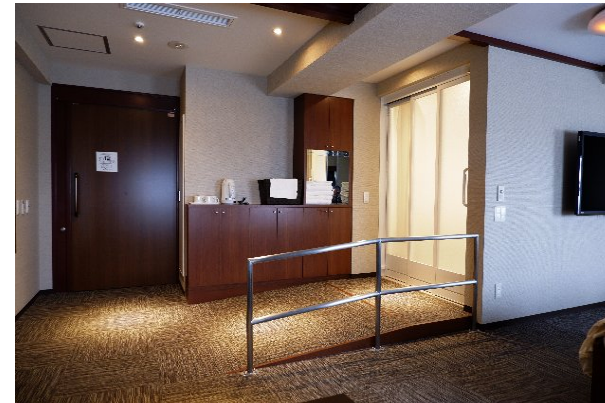
3室を1室化したうえで、浴室等の出入口の段差を解消するため、便房・浴室等の出入口前後に設けられた傾斜路 (1/12 高さ11cm)
