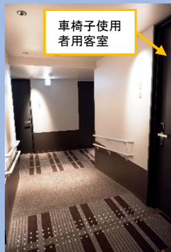
共用廊下のスロープ設置により段差解消（車椅子使用者用客室内のフラット化）
