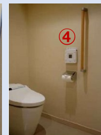
便所の垂直手すり
