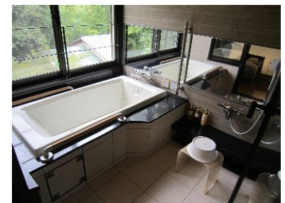
風呂（窓際） 移乗台及び横手すり（2カ所）、縦手すりが設けられている。
