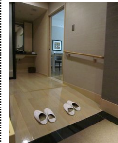
玄関スロープ（客室内） 横手すりが片側に設けられている
