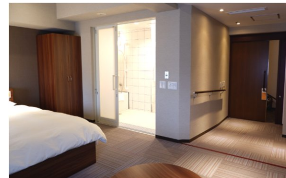
浴室等の出入口の段差を解消するため、客室の出入口付近に設けられた傾斜路 (1/10 高さ16cm)
