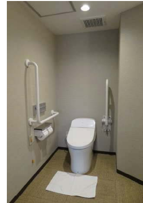
便所 L型手すり、可動式手すりが設けられている。
