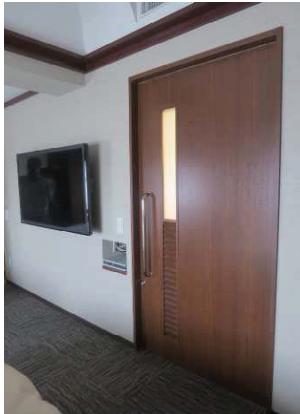
便所・洗面所出入口 便所・洗面所の出入口は引込み戸となっている。
