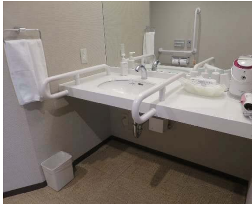
洗面所 洗面台(天板の高さ：76cm)は洗面器が一体になっている。 足元にはスペース(高さ：70cm)が設けられている。
