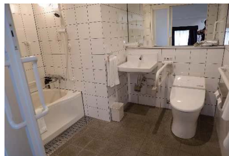
水廻り室内部
