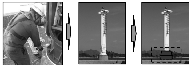
緊急点検を実施
